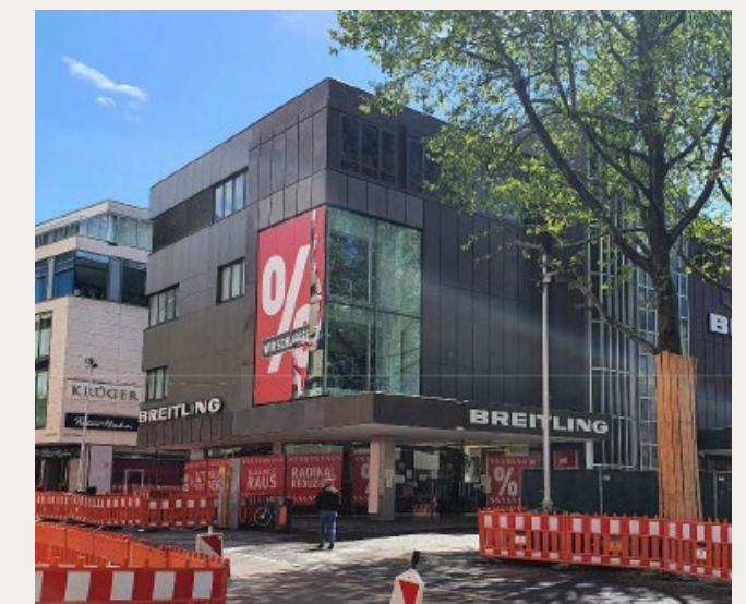
Bestandsgebäude vor dem Rückbau
